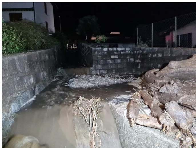
Foto 4 Depositi nella vasca riale Bruga.
