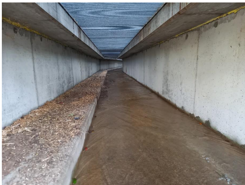
Fig. 18 Esempi di sottopassi con 1 o 2 banchine di transito: riale Bella Cima (Stabio).
