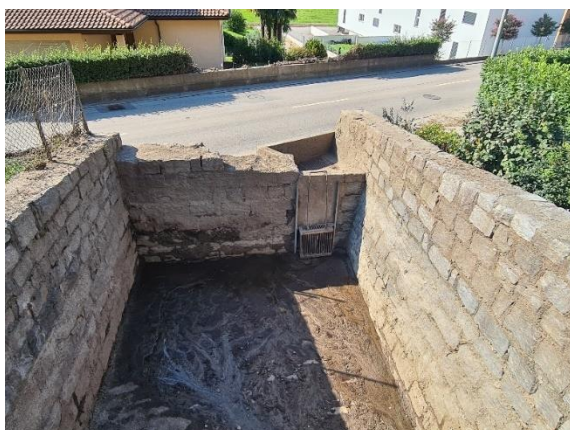
Foto 5 Vista della vasca con saracinesca di scarico.
